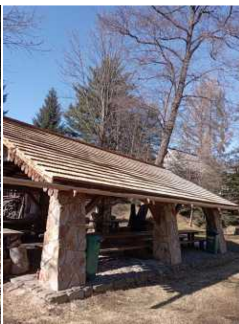
Nowy dach na wiacie grillowej
