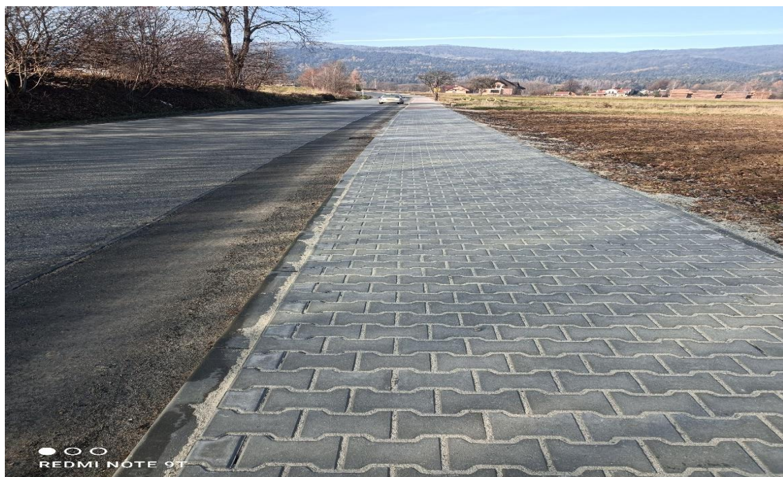
Fot. 2 Budowa chodnika w ciągu drogi powiatowej nr 1677K w Sidzynie
